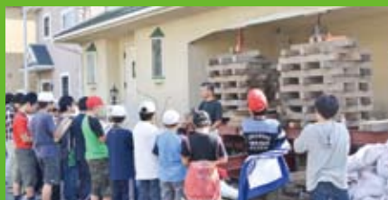
見明川小6年生が土台揚げ工事の見学に来てくれました
